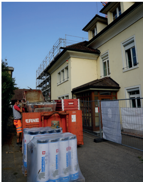
Der Vorbau des Altbaus wird abgerissen; Alt- und Neubauftrug bilden inskünftig eine gerade Flucht.
